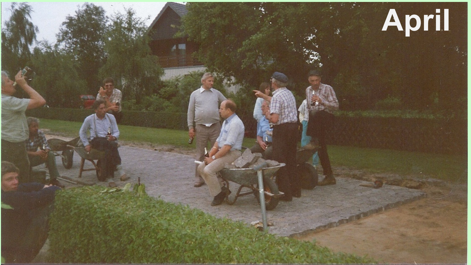
Foto: Brigitte Brösicke, Straßenbau Papenkamp in Eigenleistung 1988
